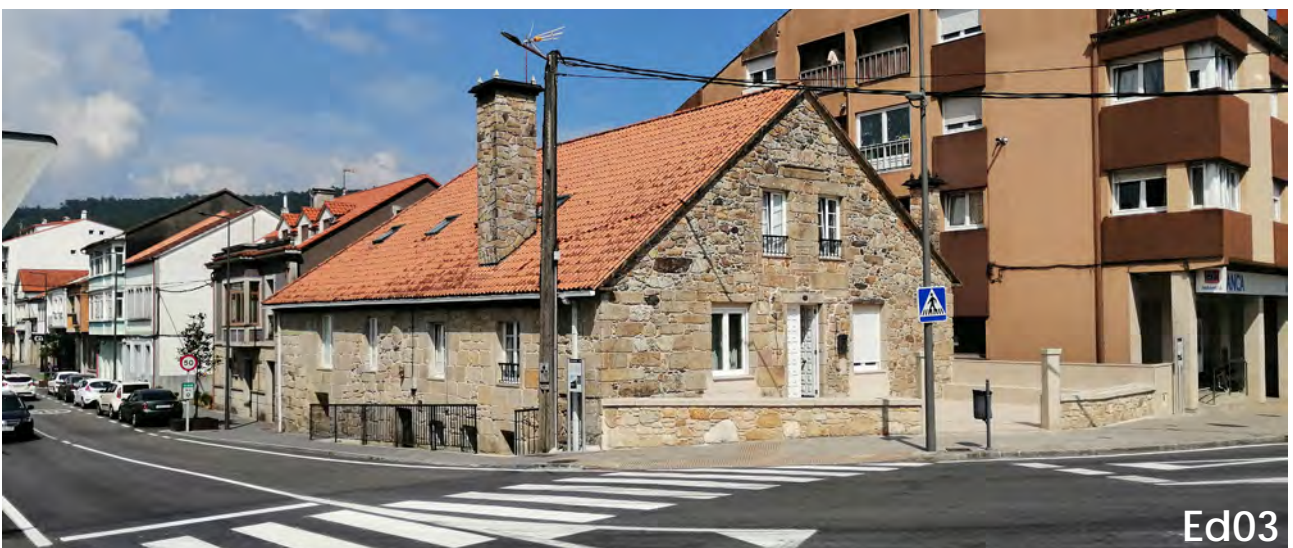
Figuras 51-54. Imaxes de edificacións (elaboración propia 2023).
