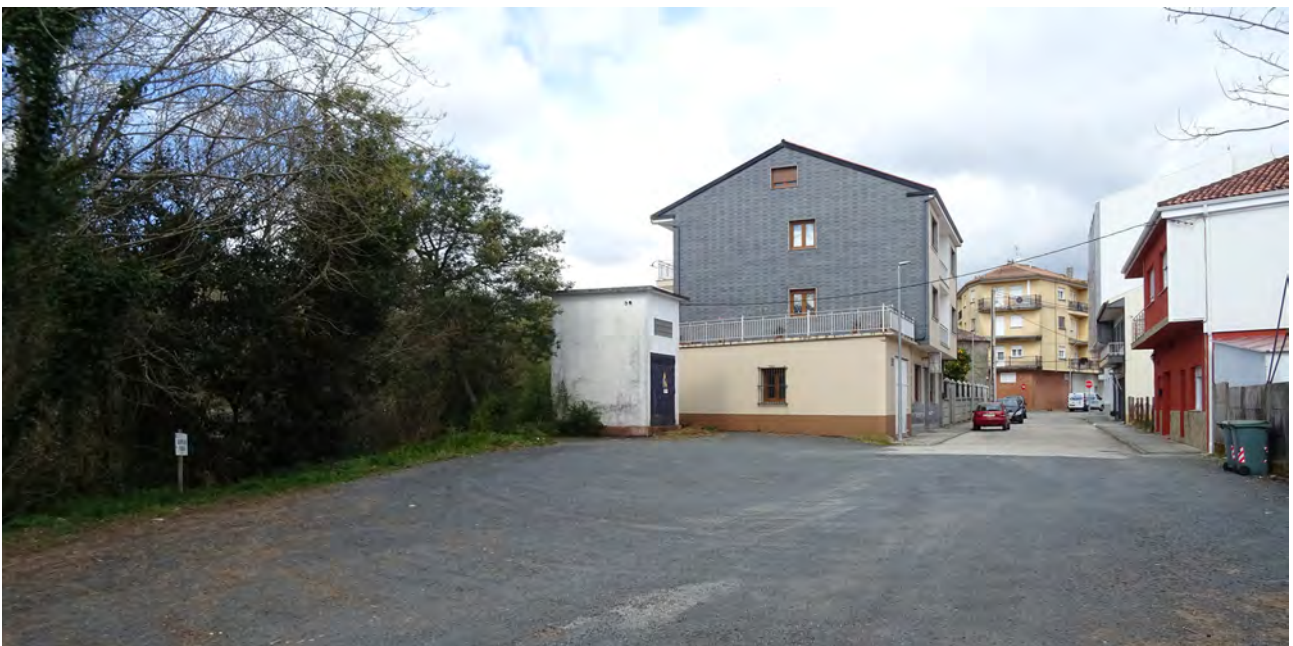
Figura 96. Fotografía da zona do transformador (elaboración propia 2023).
