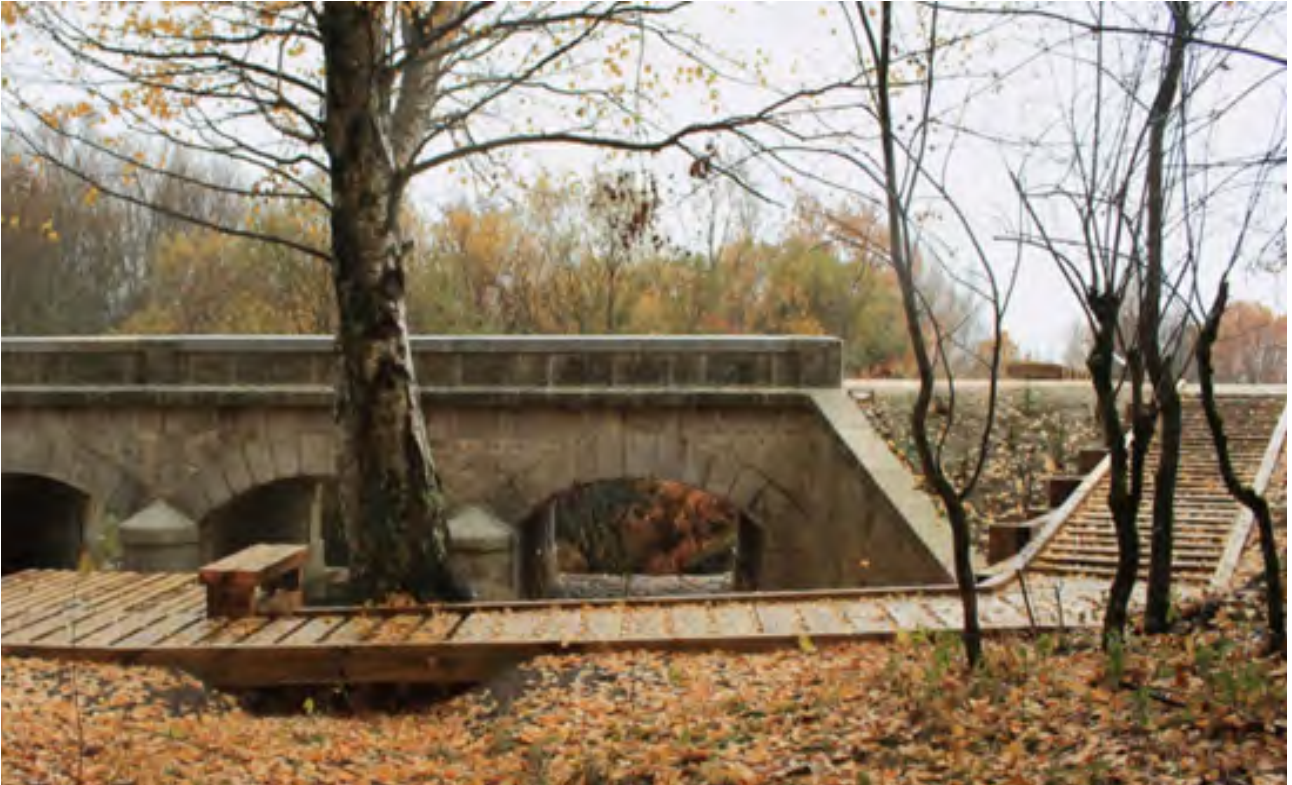
Figura 10. Acondicionamiento del entorno del Puente de Piedra (David Sánchez y Carmen Bueno, 2014)
