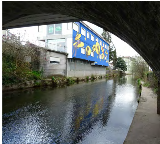
Imaxen Ou_ Fondo do río e canalización
