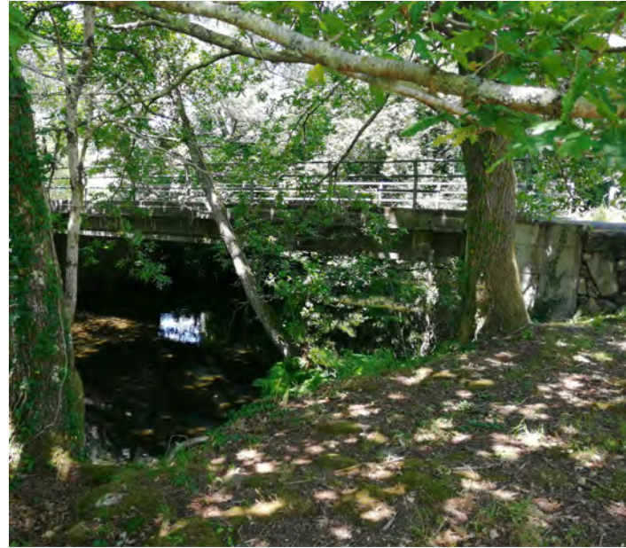
Imaxen P01_ Ponte rúa Capela
