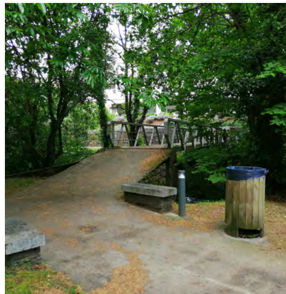
Imaxen P05_ Pasarela parque fluvial.
