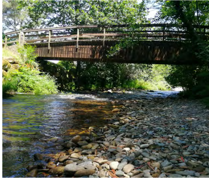
Imaxen P02_ Pasarela madeira parque fluvial.
