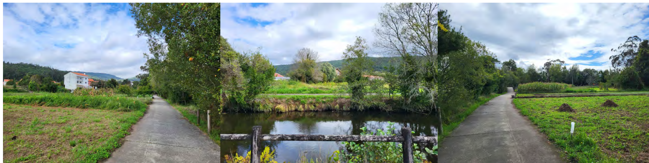
Foto estado actual.
