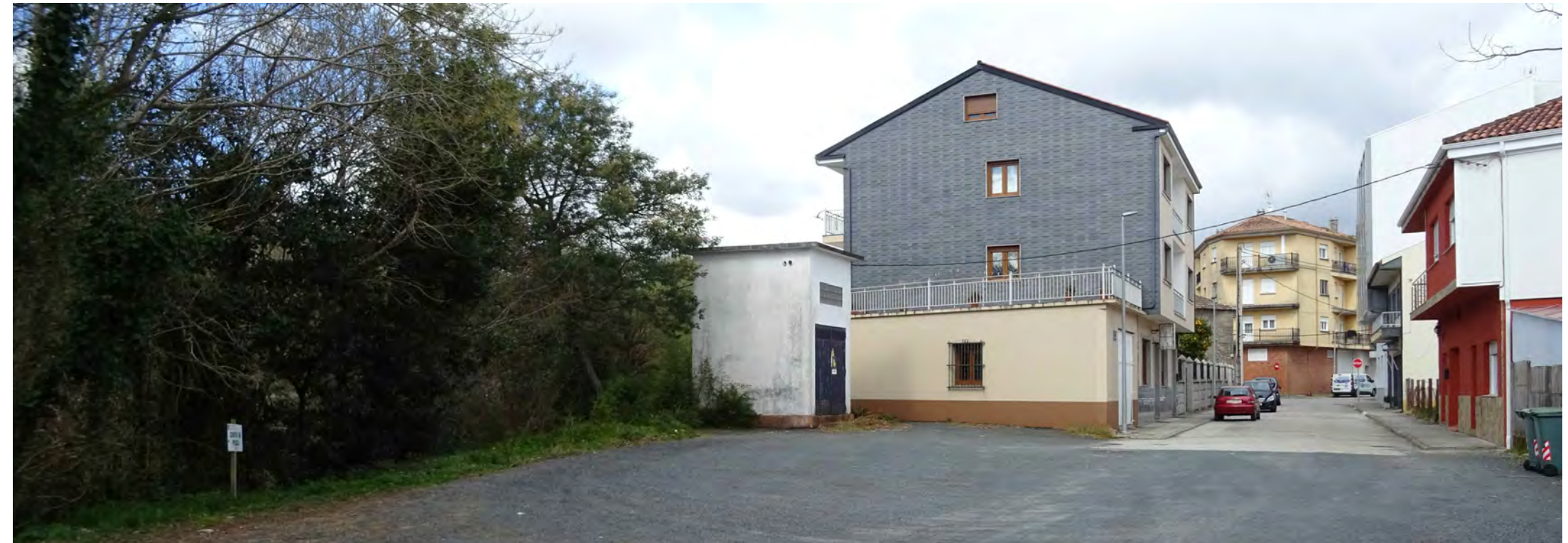
Foto estado actual.
