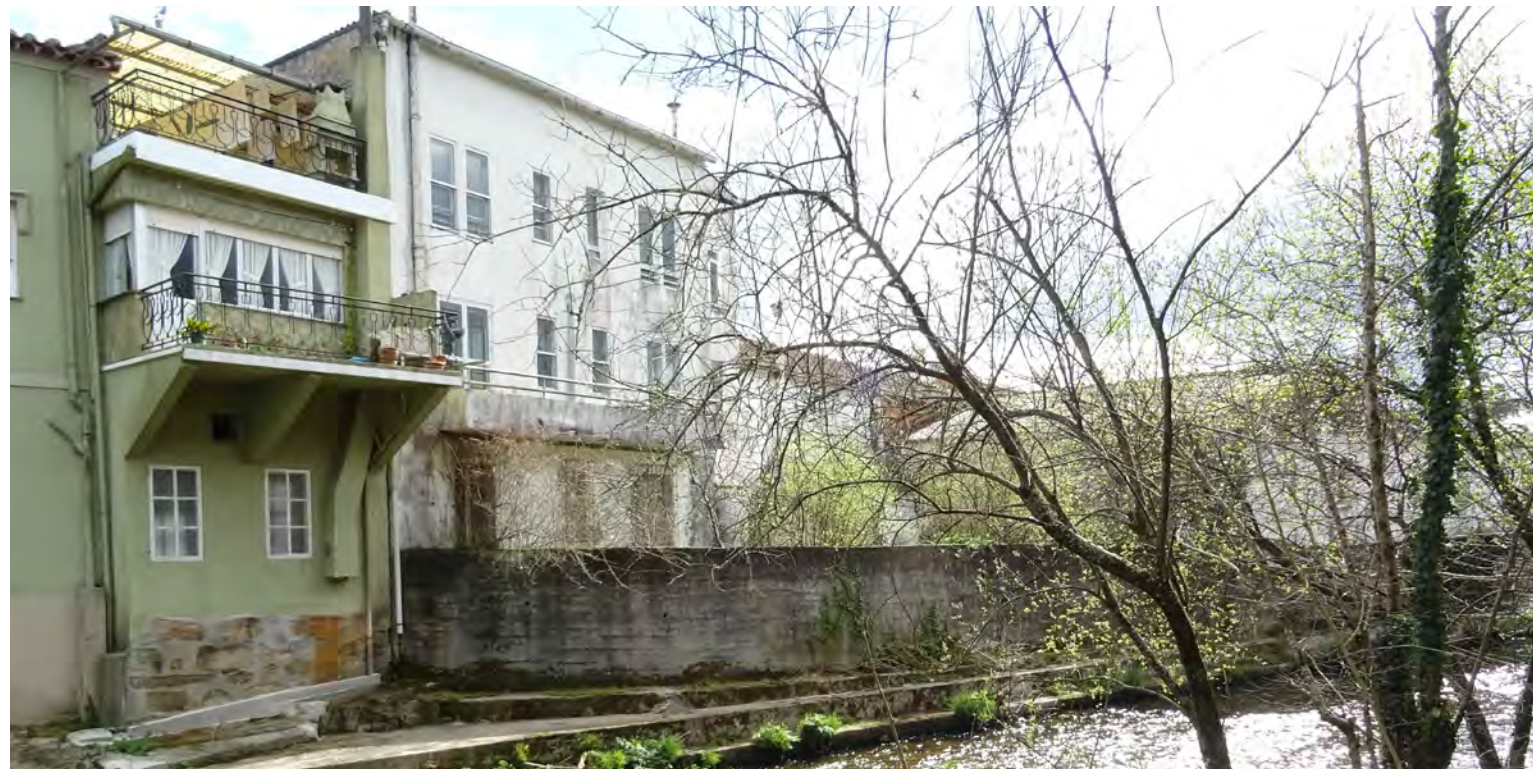
Foto estado actual.
