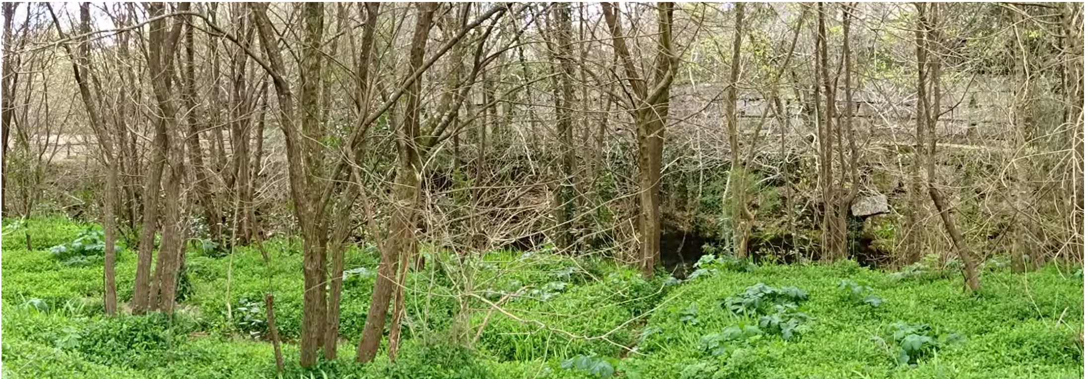
Foto estado actual.
