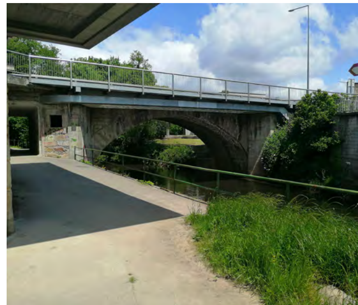
Imaxen P06_ Ponte da Serra.
