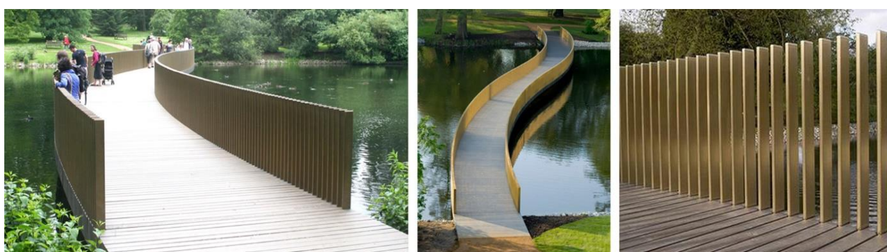
Рис. 2. Пешеходный мост в ботаническом саду Кью [6]
